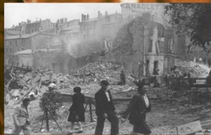
Rue de la Corde.
